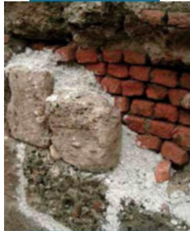
Sahada harç kullanarak nem alıcı kaba sıvanın yeniden inşası
