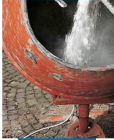
Harcın sahada yerel kaynaklı agregatlarla karıştırılması
