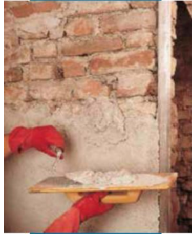
Nem alıcı kaba sıva karışımının sahada uygulanması
