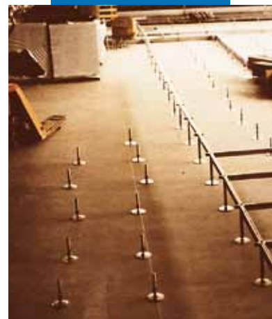
Ultraplan ile tesviye edilmiş, yükseltilmiş döşeme uygulamaya hazır alt yüzey
