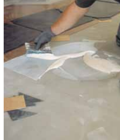
Ultraplan ile tesviye edilmiş bir yüzeye marley PVC uygulaması örneği - CD2 - Milano - İtalya
