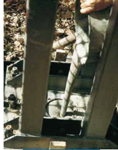
Yapısal çelik işinde Mapecoll E ile ankraj yapılması
