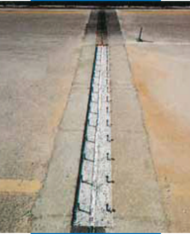
Bir otoyol köprüsünün rijit derzlerinin Mapefill E ile onarımı
