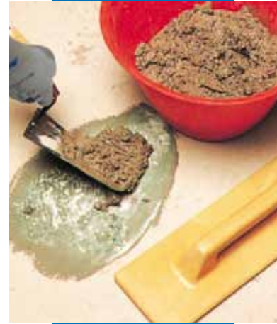
Zeminde yama yapılması: harcın uygulanması
