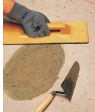
Zeminde yama yapılması: bitirme tesviyesi
