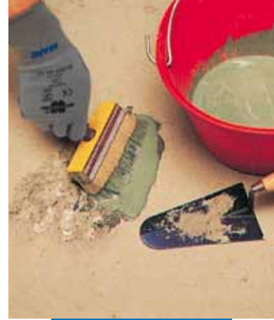
Zeminde yama yapılması: şerbetin uygulanması
