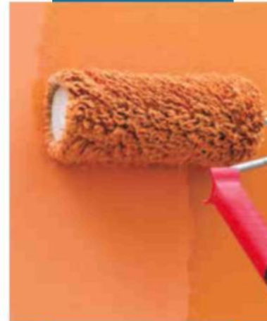
Mapetherm Flex RP 0,5 mm'nin üzerine ruloyla Silancolor Paint Plus uygulayarak yüzeyin bitirme işlemini gerçekleştirme
