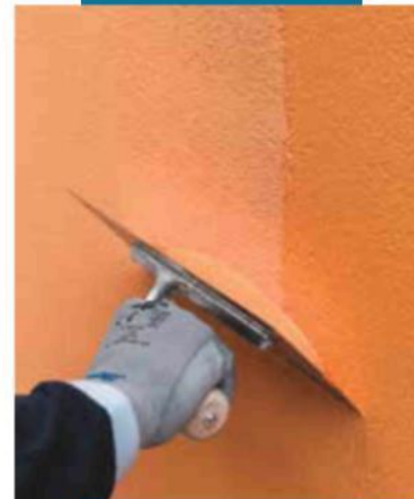
Mapetherm Flex RP 1,5 mm'nin üzerine malayla Elastocolor Tonachino Plus uygulayarak yüzeyin bitirme işlemini gerçekleştirme
