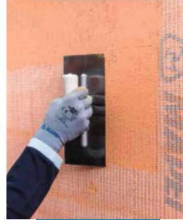
Mapetherm Net'i Mapetherm Flex RP'nin ıslak tabakasına yerleştirme
