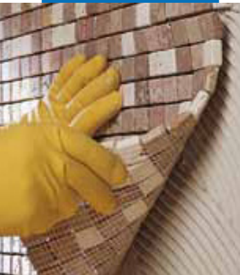
2x2 cm mermer mozaik duvara uygulanması
