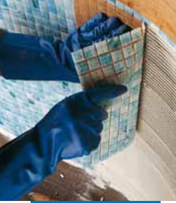
Bir yüzme havuzunda 2x2 cm cam mozaiklerin 1:1 oranında seyreltilmiş Isolastic ve Adesilex P10 karışımı ile uygulanması
