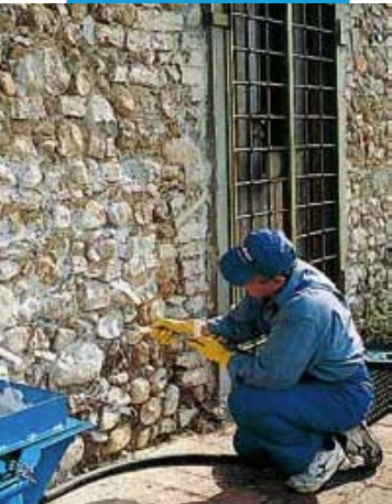
Mape-Antique I ile enjeksiyon konsolidasyonu
