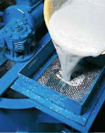
Enjeksiyon pompasının Mape-Antique I ile doldurulması
