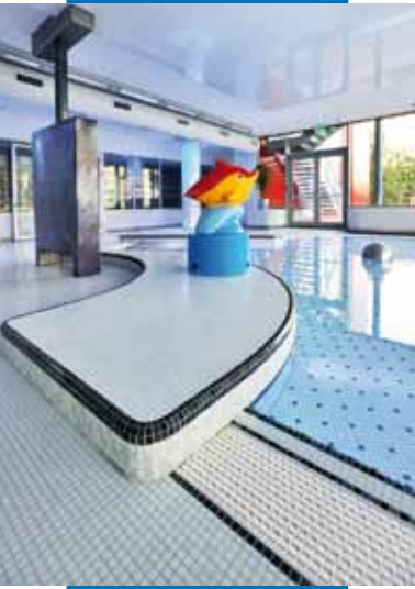
Bir yüzme havuzunda cam mozaiklerin, su ile 1:1 oranında seyreltilmiş Isolastic ve Adesilex P10 karışımı ile uygulanması Aquacentrum Pardubice, Pardubice, Çek Cumhuriyeti
