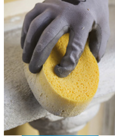
Sünger masterla Mape-Antique Ecolastic bitirmesi
