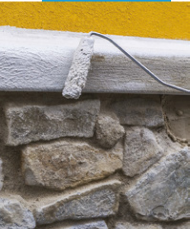
Duvar başlığına Mape-Antique Ecolastic ile su geçirmezlik uygulaması
