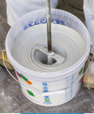
Mape-Antique Ecolastic ürününün karıştırılması
