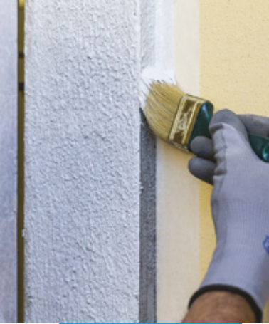
Pencere pervazının Mape-Antique Ecolastic ile korunması
