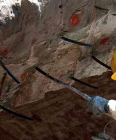
Taş yapıya Mape-Antique F21 enjeksiyonu
