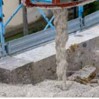
Harcın kalıba dökülmesi
