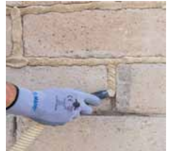
Taş duvar inşası
