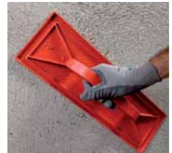
Nem atan sıvanın düzleştirilmesi
