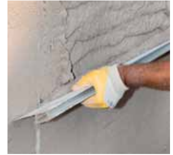
Nefes alan sıvanın master ile sıkıştırılması
