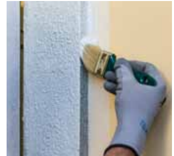
Pencere pervazının Mape-Antique Ecolastic ile korunması
