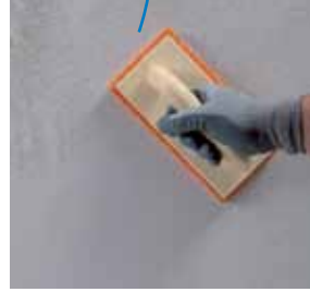
Yüzeyin korunması ve su yalıtımının yapılması
