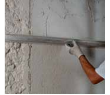
Nem atan sıvanın master ile sıkıştırılması
