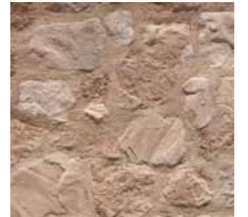
Taş cephe duvarın yeniden inşası
