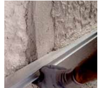
Nem atan sıvanın master ile sıkıştırılması
