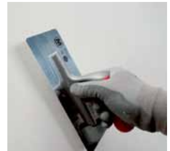
Yüzeyin düz bir metal malayla pürüzsüzleştirilmesi
