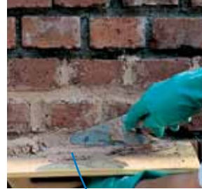
Tuğla derzlerinin tamamlanması
