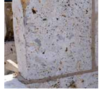
Cephe duvarın yeniden inşası
