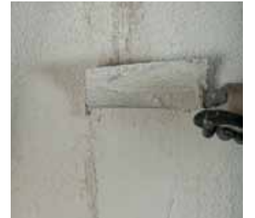
Nem atan sıva uygulaması
