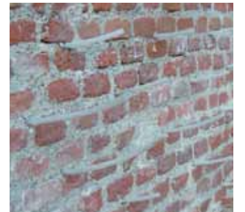
Tuğla duvarın güçlendirilmesi
