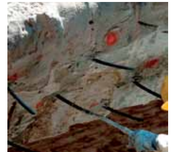
Taş yapının güçlendirilmesi
