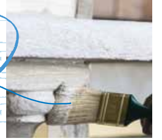
Yüzeyin korunması ve su yalıtımının yapılması
