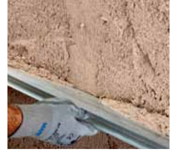
Nem atan sıvanın master ile sıkıştırılması
