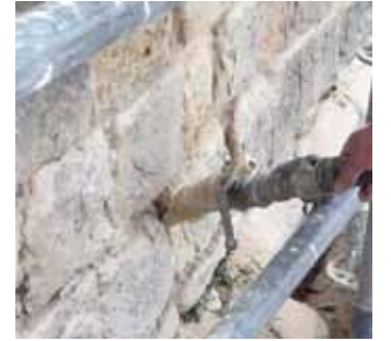
"Moloz" taş duvarların güçlendirilmesi
