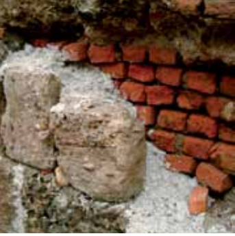
Duvarı yeniden inşa etme
