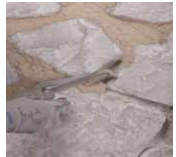
"Açığa çıkmış" duvarları derzleme
