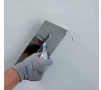
Ultra pürüzsüz dokulu sıyırma harcının ikinci katının uygulanması
