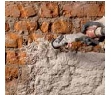
Sıva makinesi ile sıyırma katının uygulanması
