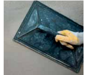
Nefes alan sıvanın düzleştirilmesi
