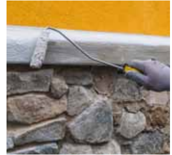
Duvar başlığına Mape-Antique Ecolastic ile su yalıtımı uygulaması
