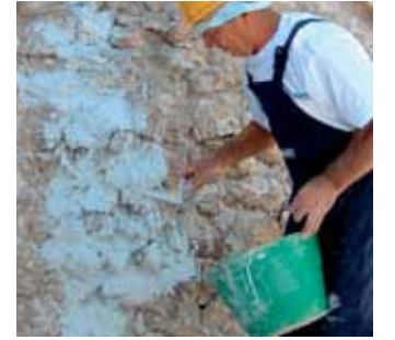
Malayla sıyırma katı uygulaması
