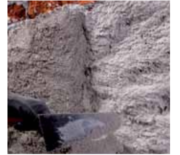
Nem atan sıva uygulaması
