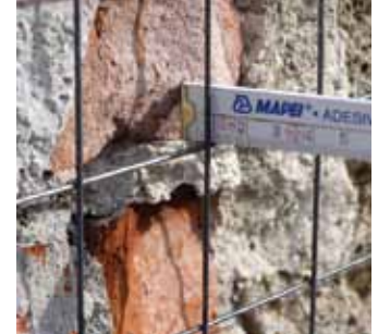
File ve alt yüzey arasındaki boşluğun kontrol edilmesi
