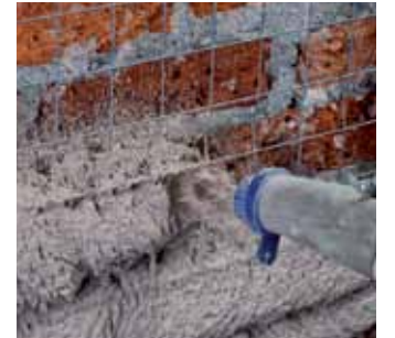
Sıva makinesi ile "yapısal" sıvanın uygulanması
